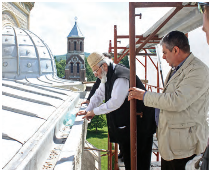
Ierarhul Calinic Argeșeanul pe schelele Catedralei Arhiepiscopale, supraveghind lucrările de restaurare
